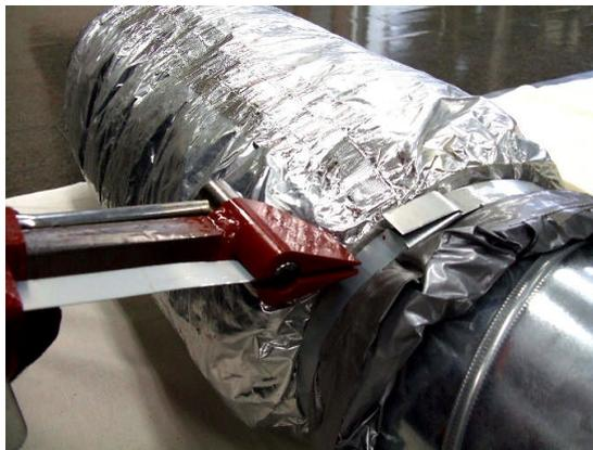
・写真の様に締付機を抜いた後、スチールバンドの折り返しの戻り防止とエアリークの防止のためダクトテープを巻き、仕上げて下さい。
