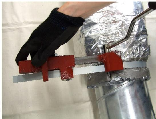
・写真の様に締付機を前側に倒したままカッターハンドルを手前に引き、スチールバンドを切断します。
